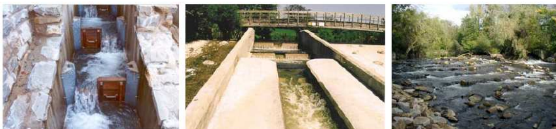
Figura 11 - Passaggio a bacini successivi, Passaggio di tipo "Denil", Passaggio a rapida artificiale. (Provincia di Mantova, 2008)
